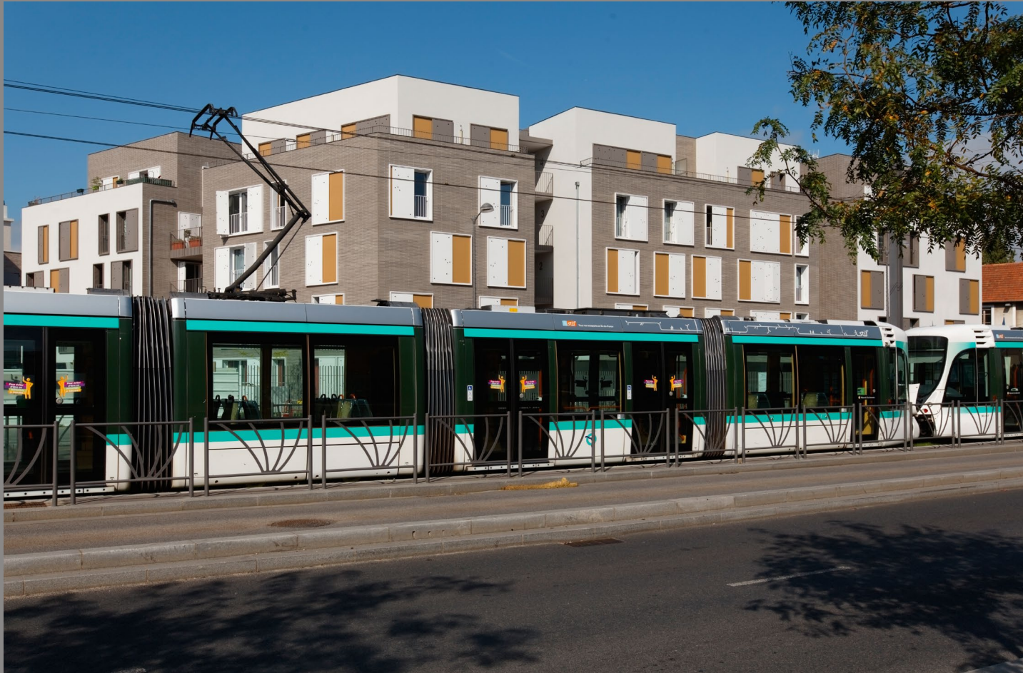
Résidence Rosenberg -Gruschkievitch & Placidi architectes
