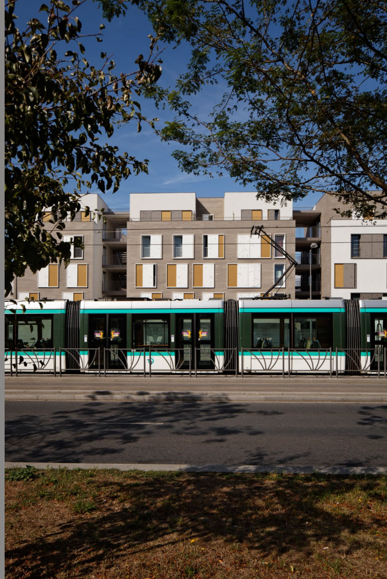
Résidence Rosenberg - Gruschkievitch & Placidi architectes
