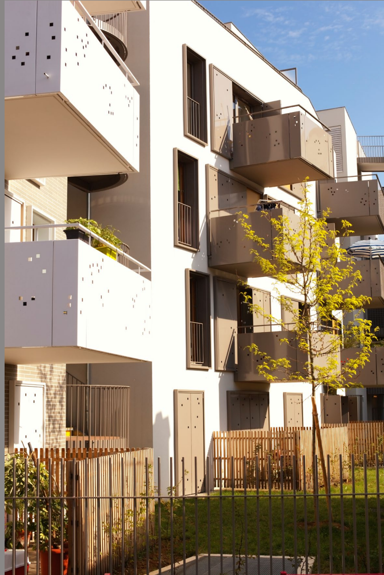
Résidence Rosenberg -Gruschkievitch & Placidi architectes
