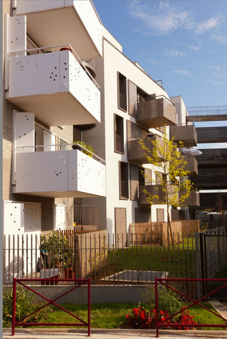
Résidence Rosenberg -Gruschkievitch & Placidi architectes
