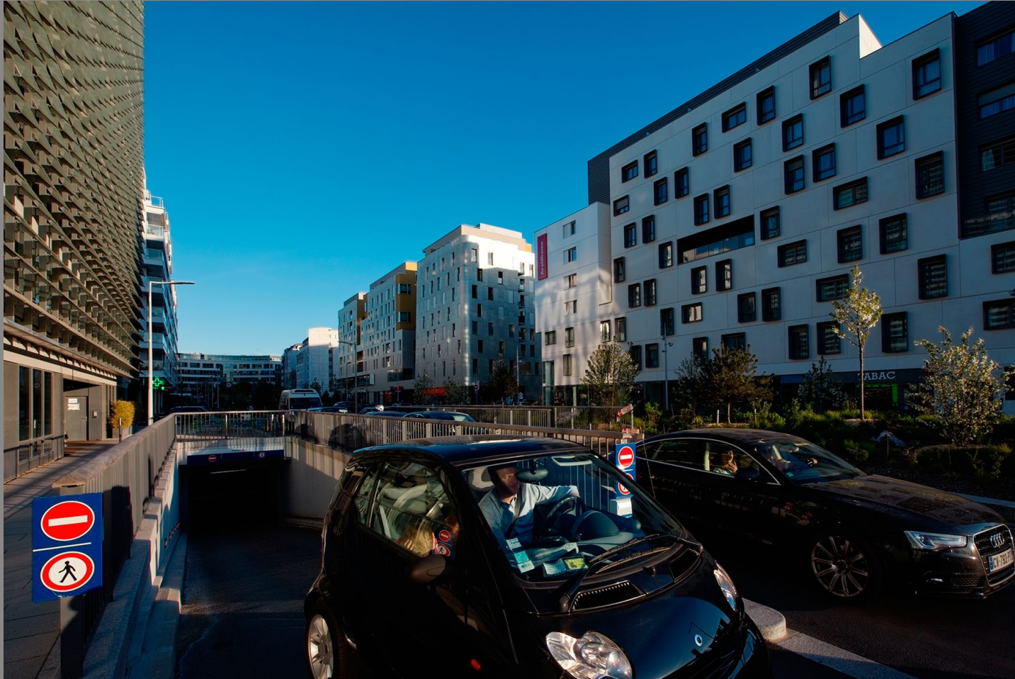
Ecoquartier des Bords de Seine - Issy-les-Moulineaux
