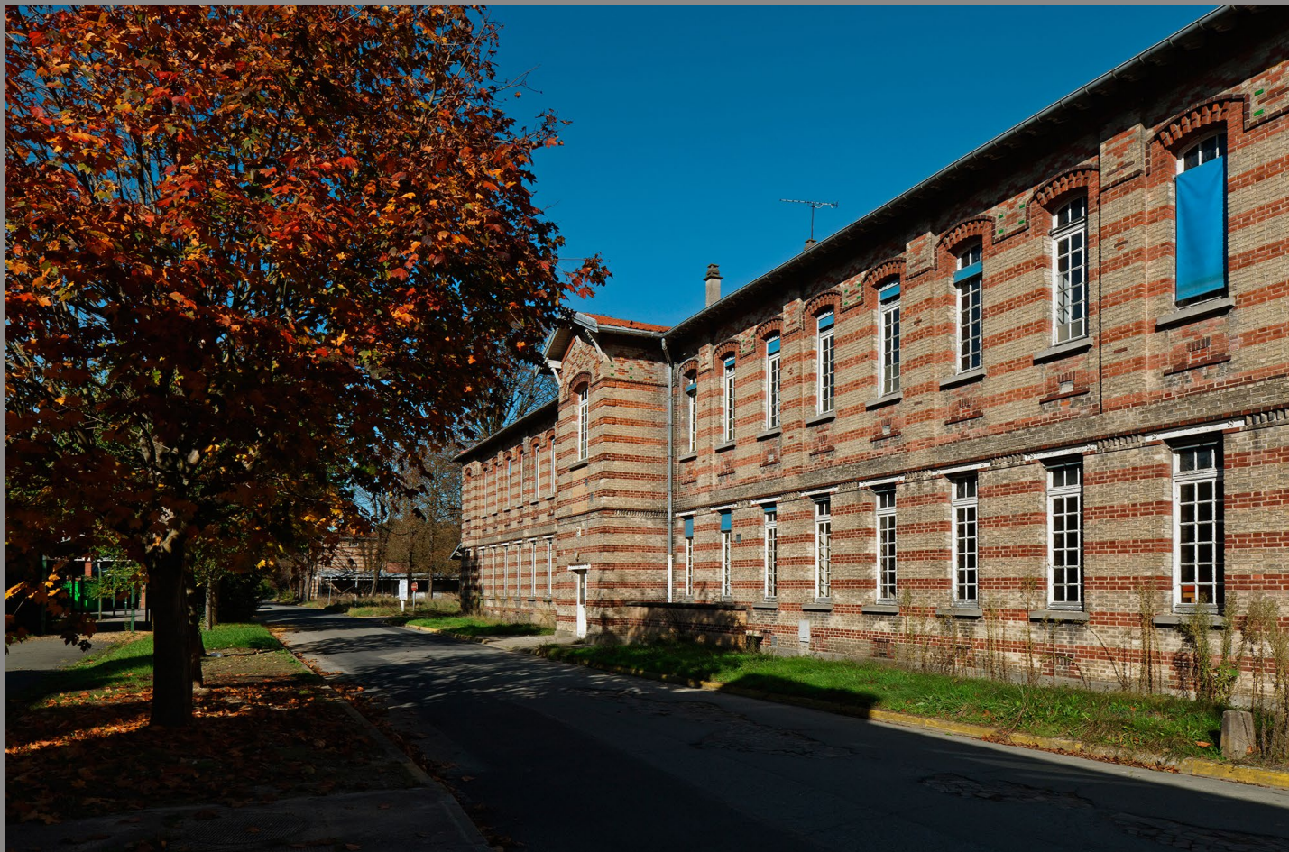
Maison Blanche - Neuilly-sur-Marne - Grand Paris Aménagement
